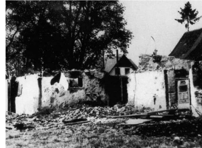
Am 1. Mai 1945 schossen französische Tiefflieger das Haus des Anton Bösch (Holzstraße 49) in Brand.
