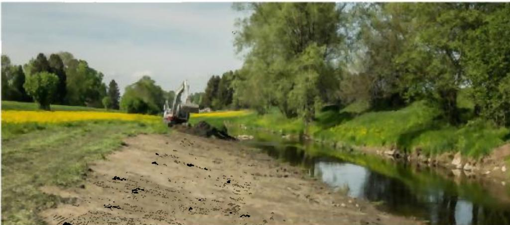
Abbildung 26: Uferabflachung an Fliessgewässer als Revitalisierungsmassnahme,
