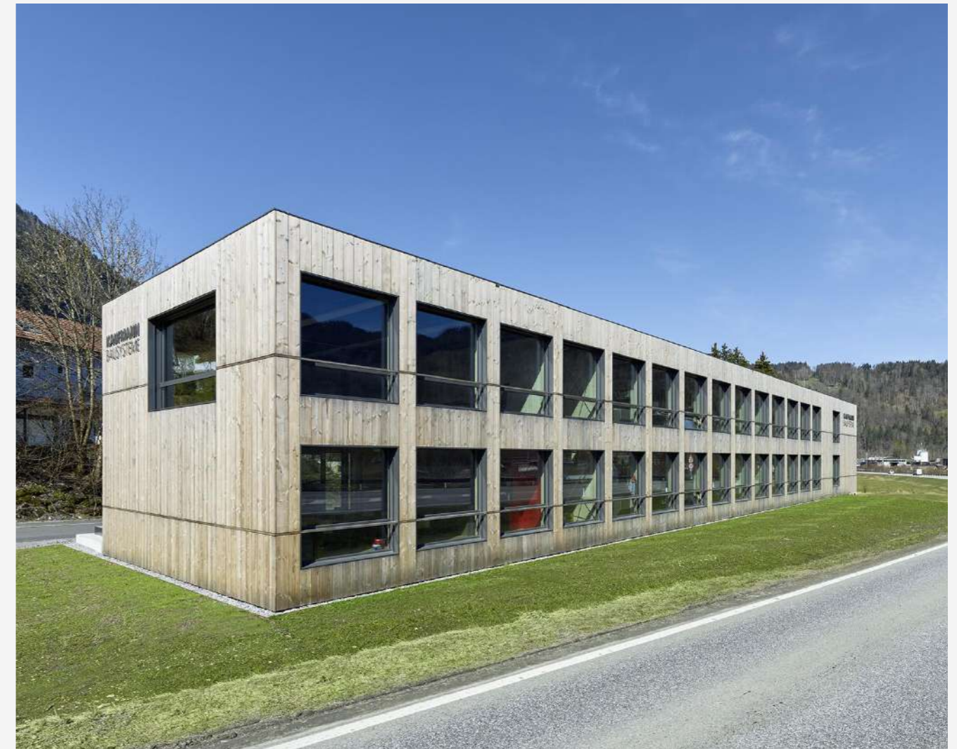
Büro Kaufmann Bausysteme | nkbak, Johannes Kaufmann, sps Architekten
